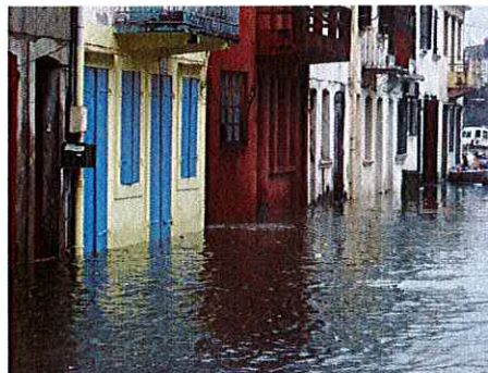
Rue inondée à St-Pierre
